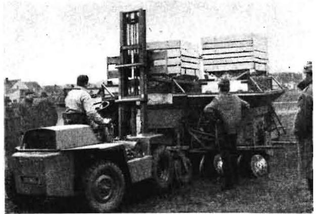
Bild 6. Direkte Befüllung einer sechsreihigen Kartoffellegemaschine (Spezial-Gitterboxpalette mit selbstschließendem Boden)
