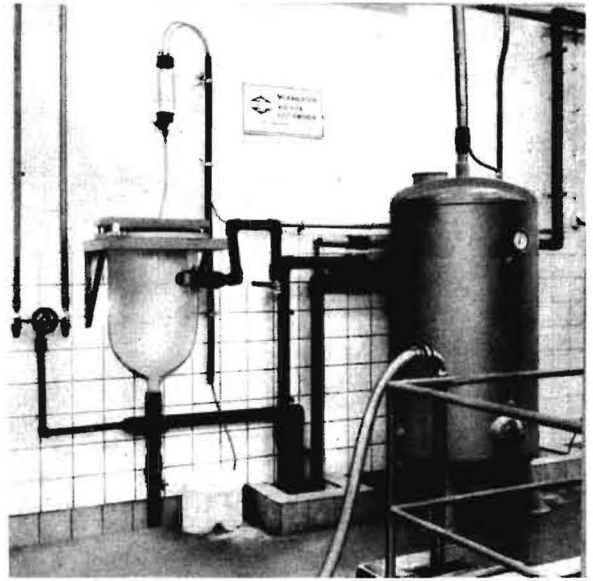
Bild 6. Milchbehandlungsraum mit Spülflüssigkeitsbehälter und Ausgleichsbehälter
