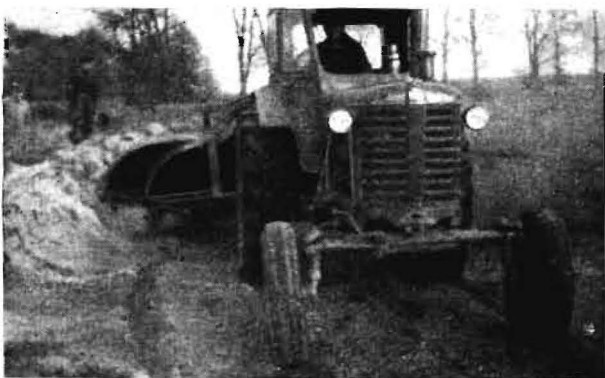
Bild 4. Steinfreier Bodenaushub des T 157 kann mit dem Aushubverteiler „Holzendorf“ verteilt werden
