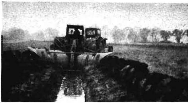
Bild 3. Einsatz des Grabenpfluges B 700 auf Niedermoor
