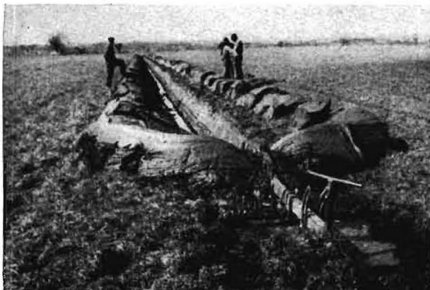
Bild 1. Grabenpflug bei der Arbeit
