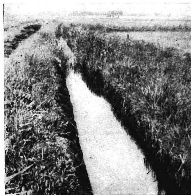
Bild 10. Graben nach dem Prinzip der Voraufbehandlung bearbeitet
