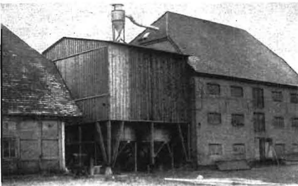
Bild 1. Zentralrohrsilos-Anlage für die Annahme und teilweise Trocknung von Getreide in Verbindung mit einem alten Speicher
