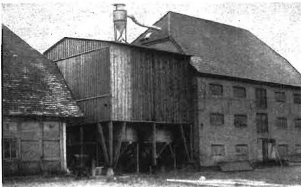
Bild 1. Zentralrohrsilos-Anlage für die Annahme und teilweise Trocknung von Getreide in Verbindung mit einem alten Speicher
