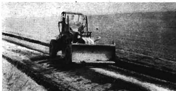
Bild 2. Straßenhobel SHM-4 beim Herstellen des Feinplanums
