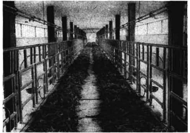
Bild 13. Von der Saffutterdosieranlage mechanisch beschickter fahrbarer Futtertisch
