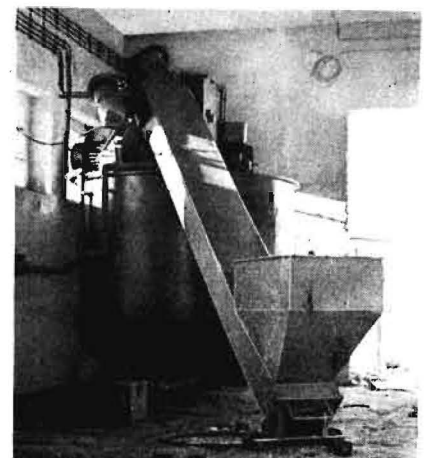
Bild 2. Aufstellung des Mischbehälters mit Beschickungsschnecke
