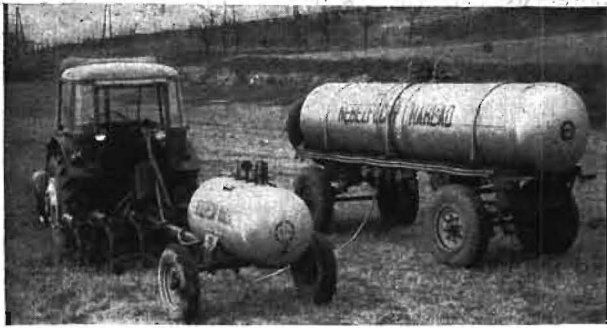
Bild 4. Ammoniak-Düngergerät für Wiesen und Weiden beim Auffüllen aus dem Straßenkesselwagen DICA-2
