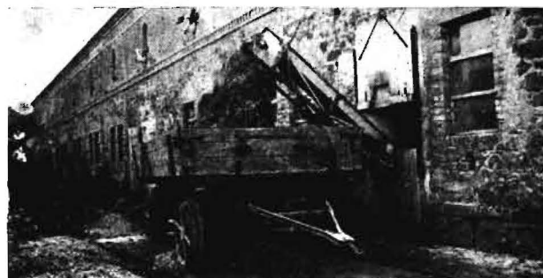
Bild 9. Beladen des zur Stallausrüstung gehörenden Misthängers durch den Schrägförderer
