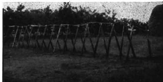
Bild 7. Prismenförmiger Hauptkanal aus gewöhnlichen Holzstangen
