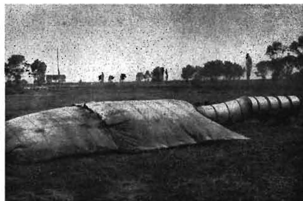
Bild 9. Trocknung mit vorgewärmter Luft unter Planen
