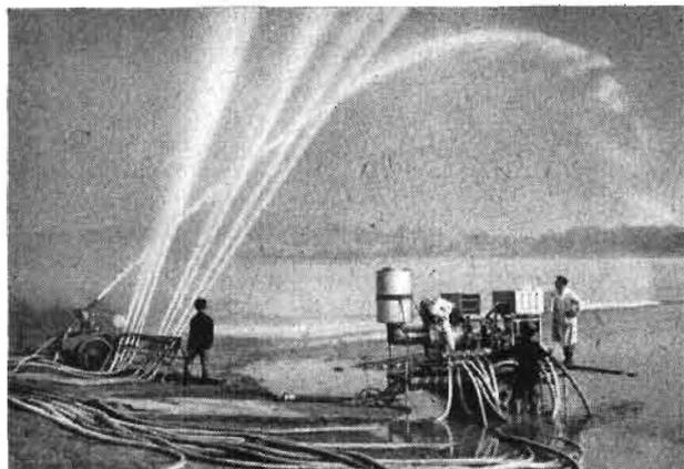
Bild 1. „Austin-250“-Industrie-Gasturbine mit einer 11350-l-Pumpe (Druck 7  $\text{kp/cm}^2$ , Saughöhe bis 30 m). Da keine nennenswerten Vibrationen auftreten, benötigt der Turbomotor keinen schweren Rahmenunterbau und kommt trotz hoher Leistung mit einem Einachsahrgestell aus
