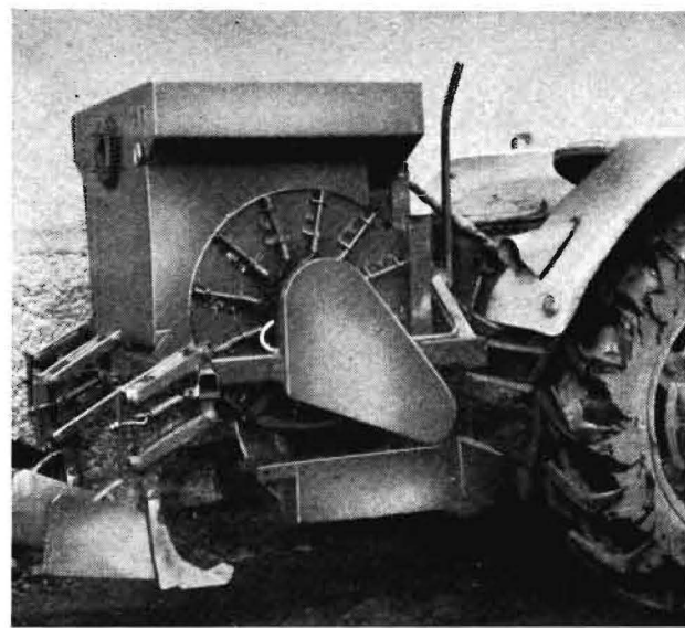
Bild 1. Zweireihige Anbau-Kartoffellegemaschine 2-SBN-62,5
