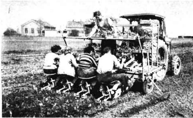
Bild 5. Pflanzmaschine A 821 mit eingebautem Transportwagen beim Aussetzen von Topfpflanzen (Werkfoto BBG)
