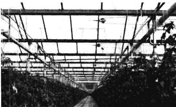
Bild 2. Betonierter Querweg von 2 m Breite, der als Verbinder dient. Im Verbindungsweg sind die Armaturen für die Klimasteuerung untergebracht
