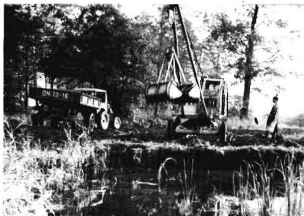
Bild 1. Selbstfahrender Lader T 170 beim Stechen von Niedermoortorf
