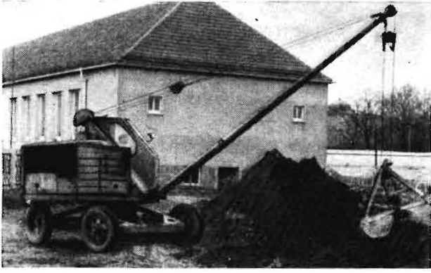
Bild 1. Selbstfahrender Lader T 170 zum Mischen der Erde
