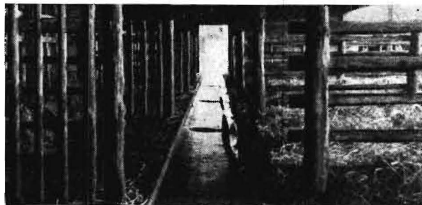
Bild 6. Ansicht des mit der Schleppschaufel gereinigten Kotgangs
