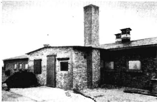
Bild 1. Heizhaus des Abferkelstalles
