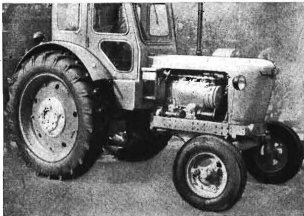
Bild 1. Radtraktor T 40 der 0,9-Mp-Klasse der UdSSR (Halbrahmenbauweise)
