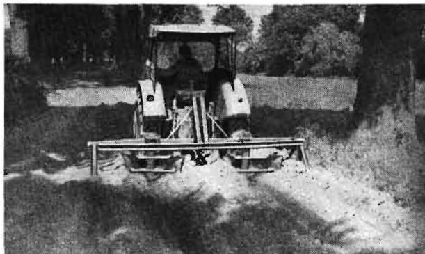
Bild 5. Häufelpflug, mit dem die Verlegerinnen für die Spurbahn-Fertigteile hergestellt werden
