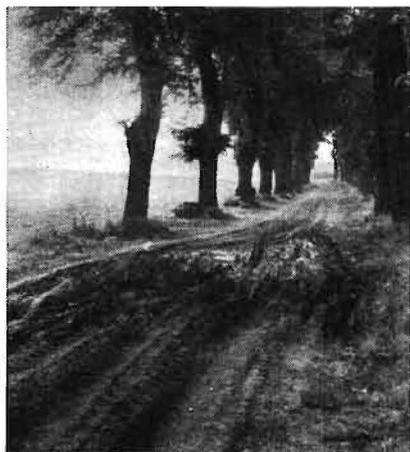
Bild 1. Hauptfahrweg mit tiefen Fahrspuren bei Niederschlägen
