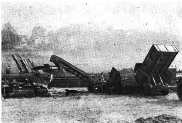
Bild 1. Förderbandkombination für den Umschlag von Zuckerrüben, eingesetzt zur Schiffsbeladung am Kai von Meißen
