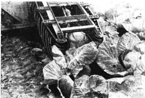
an der Dreipunktaufhängung des Traktors angebaut, daß sich der Aufnahme- und Schneidmechanismus rechts neben dem Traktor befindet. Im praktischen Einsatz hat sich die Maschine nicht sonderlich bewährt. Es traten zu viele Verstopfungen am Förderband auf. Ein Abstellen dieser Störungsquelle war nicht möglich und man führte deshalb die Arbeiten an dieser Maschine nicht weiter.
