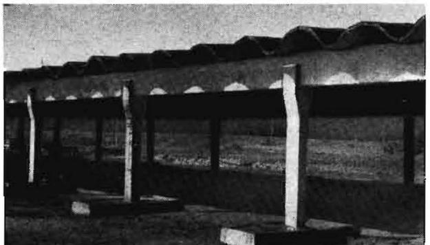
Bild 4. Offener Unterstellschuppen aus Stahlbetonfertigteilen (Wellenschalendach). Im Bild für PKW — für landwirtschaftliche Maschinen werden größere Höhen ausgeführt
