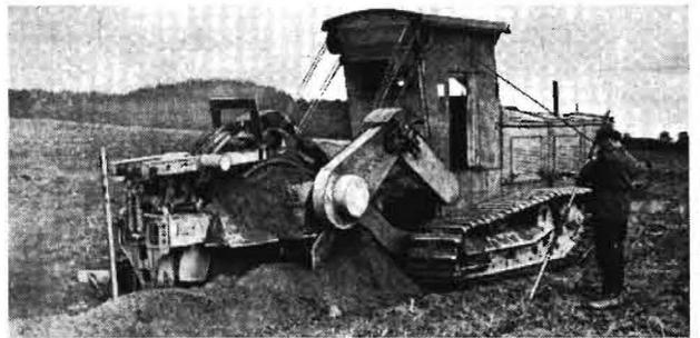
Bild 2. Fräsradsgrabenbagger 589 000
