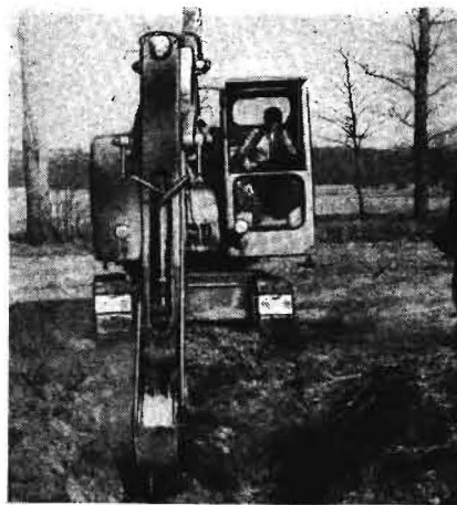
Bild 2 Universalbagger UB 20 beim Einsatz in der Dränung ▶
