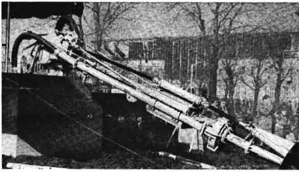
Bild 5. Saugspülbagger „Berlin“ mit Fräskopf. Auch seine Leistung reicht noch nicht aus.
