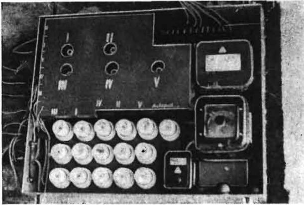
Bild 1. In der LPG „Grenzland“ Rübenuau installierter Belüftungsautomat für 5 Gebläse (geöffnet)
