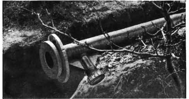
Bild 1. PVC-hart-Rohr 110 × 6,5 mit Entleerungsstutzen und Überwurfflansch NW 150
