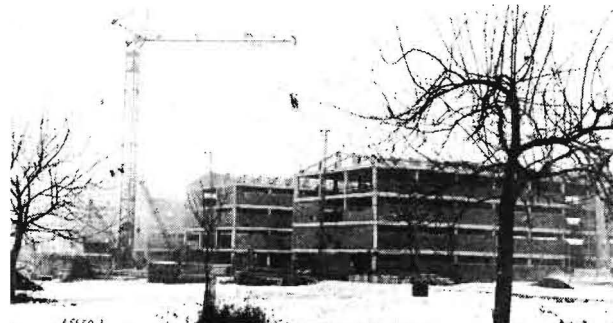
Bild 3. Mehrgeschossige Broileranlage im Bau (CSSR). Foto: CSSR
