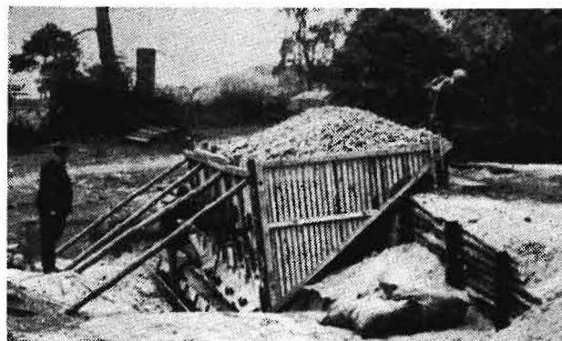
Bild 3. Vorrats- und Annahmehunker im VEG Siethen, Kr. Zossen (Holzausführung)
