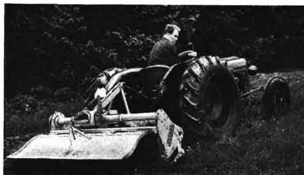
Bild 1. Zetor 3011 mit niedrigem Schwerpunkt, mit angebaute Rotator
