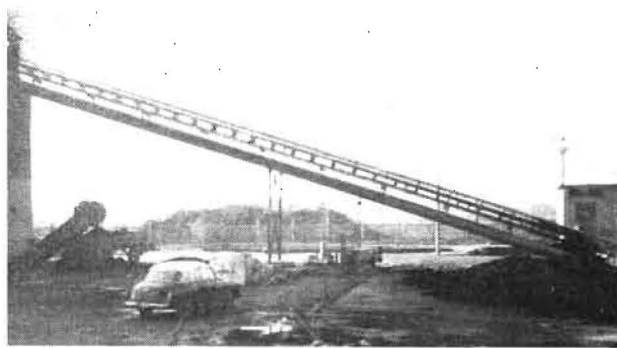
Bild 2. Bekohlungsbrücke für Standard-Trommeltrocknungsanlage
