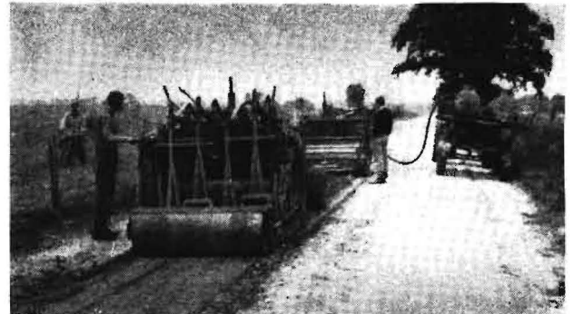
Bild 6. Das HOWARD-Maschinensystem bei der Kalkstabilisierung in der Altmärker Wische. Vorn im Bild der Mischer, dahinter das Verdichtungsgerät (Kompactor)
