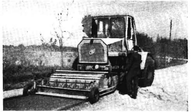
Bild 4. Eingangsmischer UZF 70 (VEB Baumaschinen Gatersleben) beim Mischen einer Zementstabilisierung
