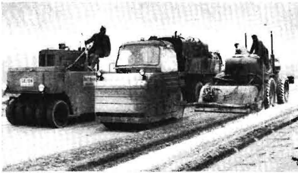
Bild 1. Teerstabilisierung (Heißeer) mit Kalkhydrat als Füllmaterial
