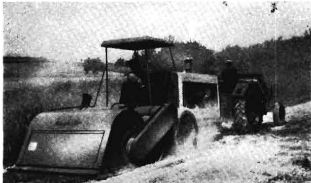
Bild 2. Kalkstabilisierung eines Feldweges in Österreich mit einem Behelfsgert
