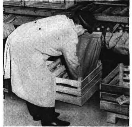
Bild 4. Schlauch zum Abfüllen der kalibrierten Früchte (Vorratsfach wird gesperrt, Obst gleitet aus dem Schlauch in die Steige)
