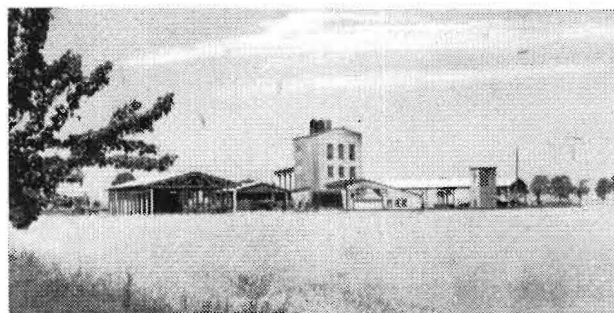
Bild 1. Trocknungsanlage Fischbeck, Kreis Havelberg: Schwesterbetrieb der Trocknungsanlage Sandau (Fotos: PFEIFFER / LANGE)
