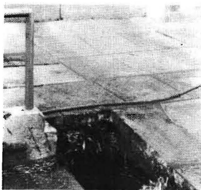
Bild 3. Einlaufstelle der Kratzerkette, die Kotrinne (Mitnehmerbahn) liegt 400 mm unter dem Stallquergang
