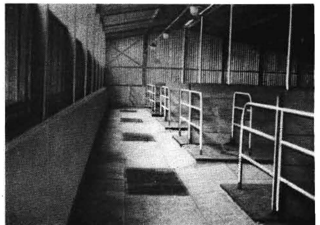
Bild 7. Liegeboxen mit Gußasphaltbelag und mit Rosten abgedeckte Einwürfe der Schwemmenmischung
