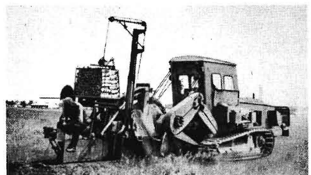
Bild 1. Im VEB Meliorationsbau Rostock umgebaute 589 000 in Arbeitsstellung
