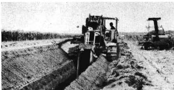
Bild 2. ETN-171 während der Seiteneinnahme von Zuschlagstoffen
