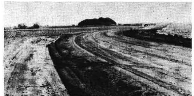
Bild 4. Grabentrasse nach der Verfüllung. Verbleibende Restmulde wirkt nicht verkehrshindernd
