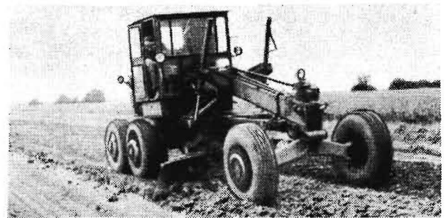
Bild 3. Verfüllen des entstandenen Grabens mit dem Straßenhobel
