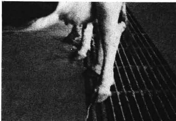
Bild 2. Gitterrost aus Rundstahl, kombiniert mit Winkelstahl an der Standseite
