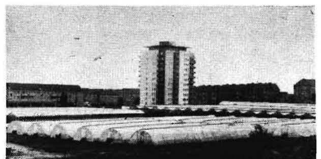
Bild 1. Blick auf eine Plastfoliengewächshausanlage im VE Gartenbau Eisenhüttenstadt
