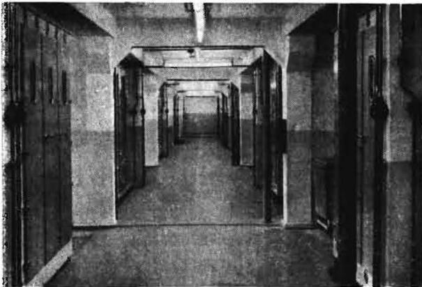
Bild 5. Vorbrutschränke im 1. Obergeschoß des Bruthauses. Der Fußboden hat einen Belag aus GVP, wodurch Feuchtigkeitdurchgang verhindert und im Brutraum für die notwendige Luftfeuchtigkeit gesorgt wird
