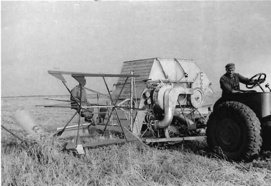
Bild 2: Gezogener Querflußmähdrescher, 1937 „Mähdreschbinder“, Werkbild Claas
