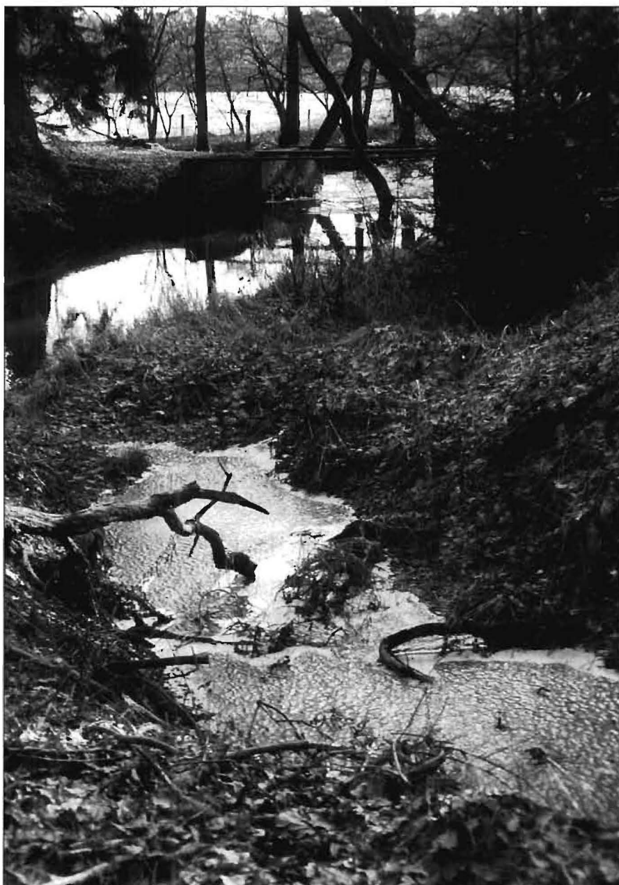
Reste der historischen „Herrenschleuse“ mit beginnendem „Herrengraben“
