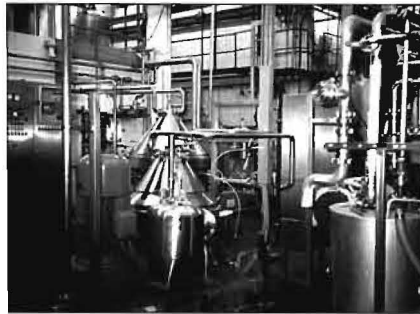
Technisches Zentrum der Remstallkellerei in Weinstadt-Beutelsbach
