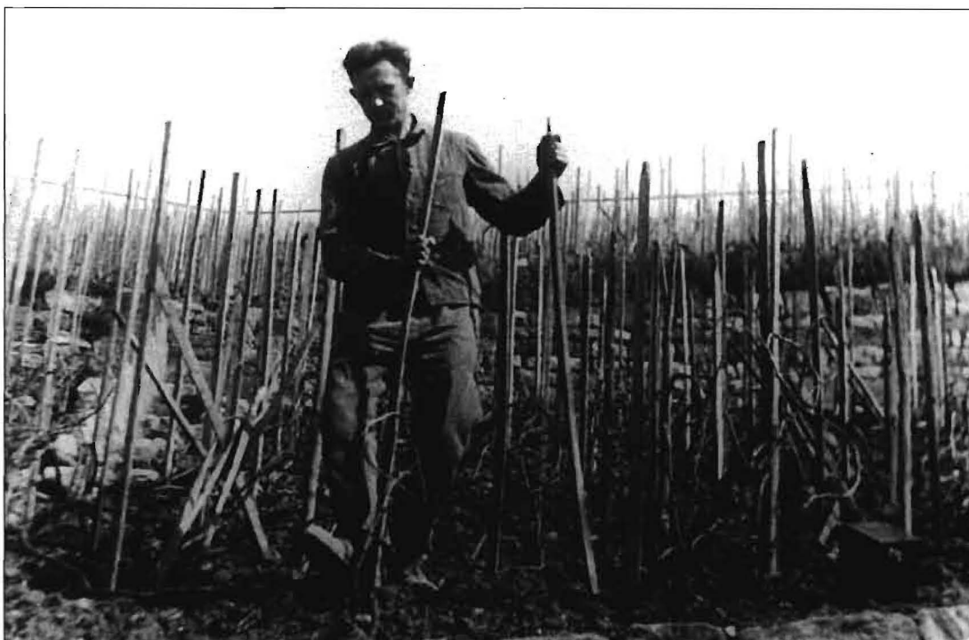
Pfähle stecken mit dem Pfahleisen am Fuß
