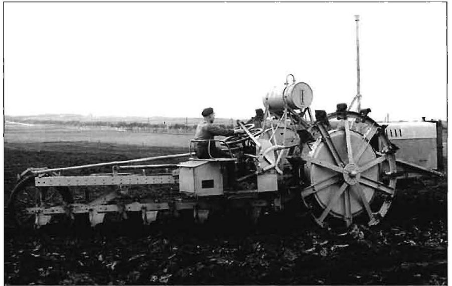
Bild 1: WD-Großpflug bei der Bodenbearbeitung am Vorabend des Ersten Weltkriegs
